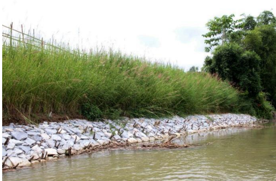
Bờ sông sau khi đã được bảo vệ hoàn thiện
