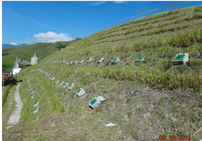
Cỏ Vetiver kết hợp với phương pháp Soil nail tại Colombia
